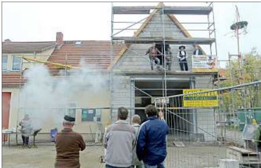
Im vergangenen Jahr wurde am Feuerwehr-Gerätehaus in Kleinromstedt Richtfest gefeiert. Die Feuerwehrleute haben nun bessere Bedingungen. Foto: Peter Hansen
