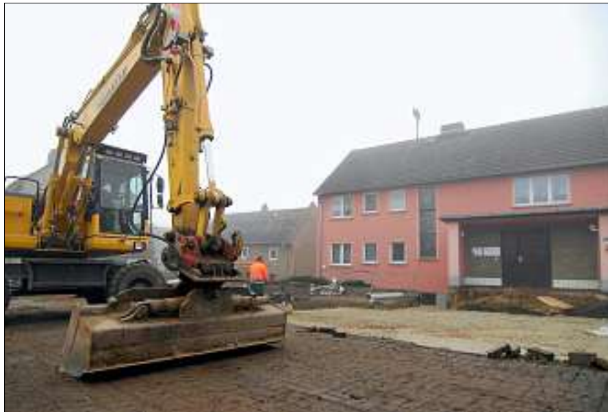
Derzeit wird am Ärztehaus in Wormstedt das Terrain für die Bodenplatte des Anbaus vorbereitet. Zudem entstehen etliche Patientenparkplätze. Foto: Dirk Lorenz-Bauer
