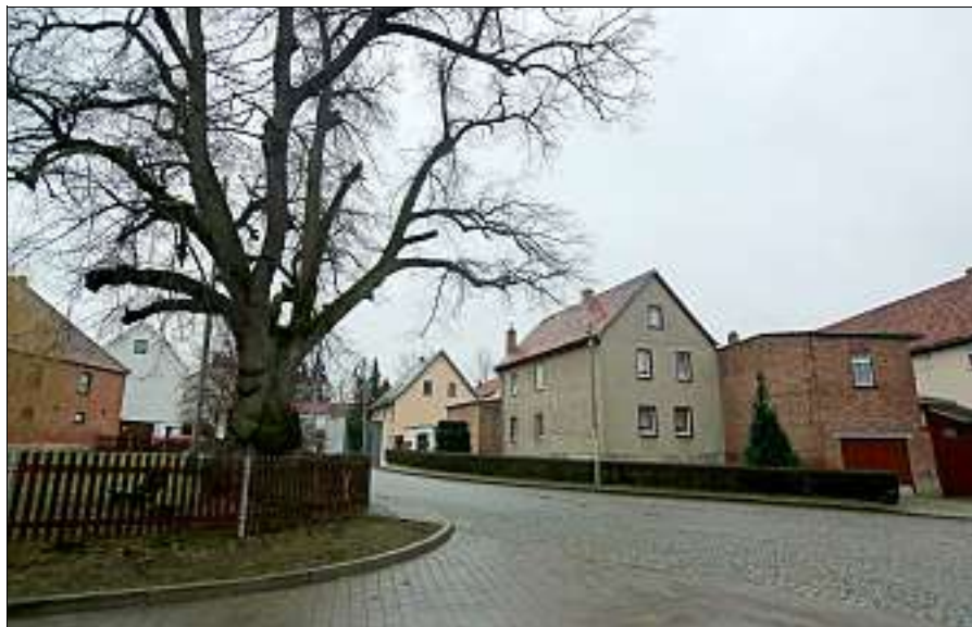
Hübsche Häuschen, alte Bäume und neues Pflaster auf der Dorfstraße – so präsentiert sich Pfuhlsborn zum Jahresbeginn. Foto: Peter Hansen
